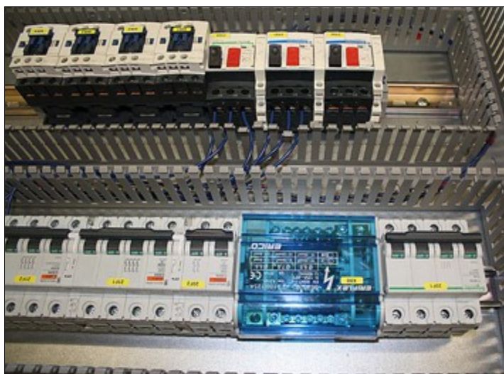
Het bestücken van de robot gebeurt nog manueel. De robot doet de routing en de bedrading
